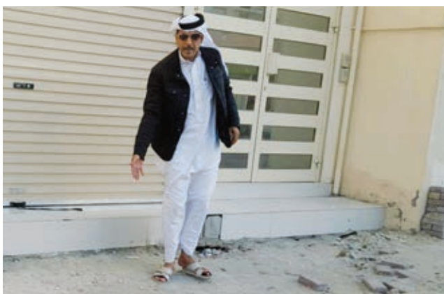
أعمال الإنشاء على الأرض.
